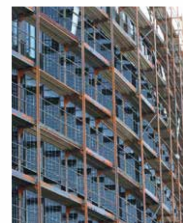
Façade brise-soleil au nouveau centre administratif à Freiburg (en construction)
