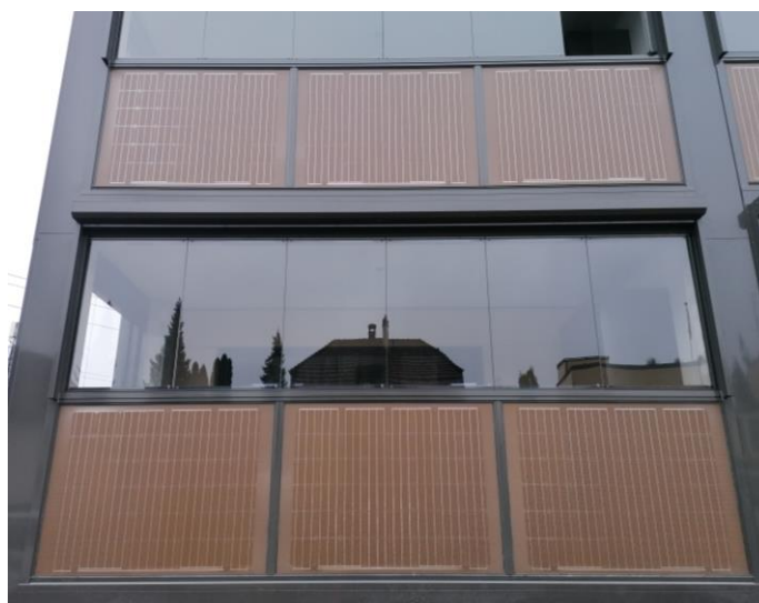
als integrierte Baukomponente mit Glas-Siebdruck
